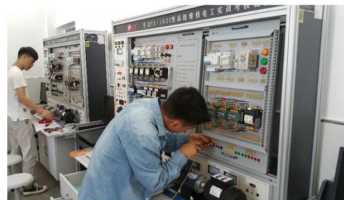
高级电工实训室
